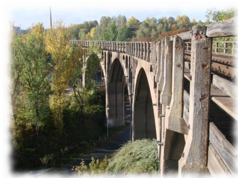
Der Schmalzgrund-Viadukt in Hettstedt.
